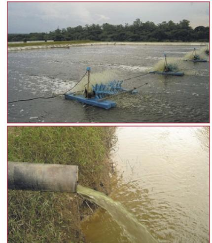
Fig. 10 - Operação dos aeradores (acima) e efluente final sendo descartado no corpo receptor (abaixo)
