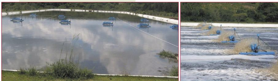
Fig. 3 - Instalação dos aeradores vista da entrada da lagoa (à esq.) e início da operação (à dir.)
